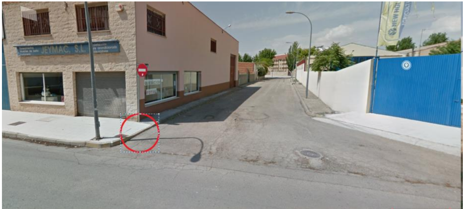
Foto 2 calle Miguel Angel Blanco, detalle de barreras arquitectónicas intransitable para carros y sillas de ruedas.
